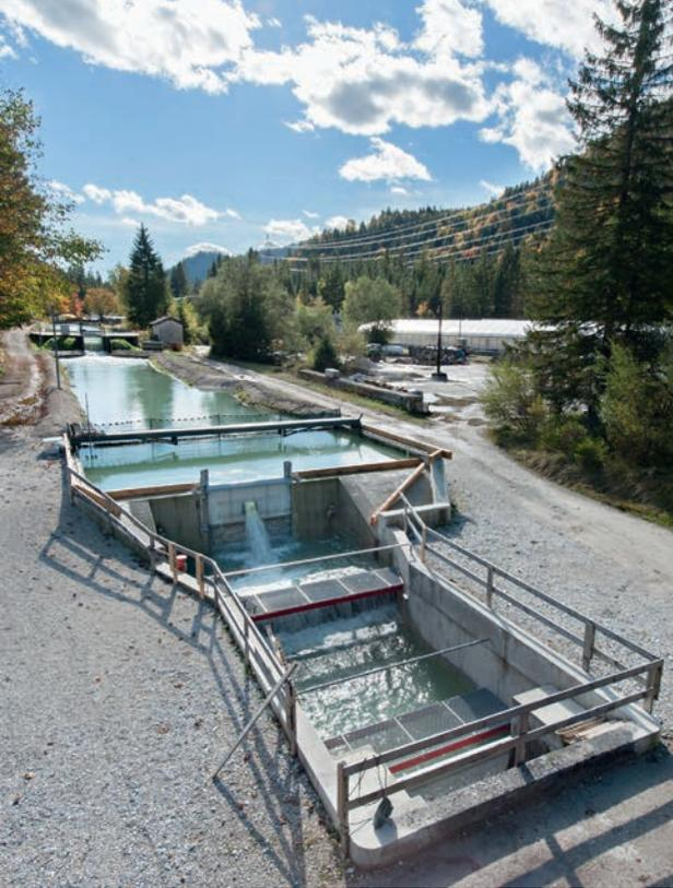
Prototyp des an der TUM entwickelten Schachtwasserkraftwerks in der Versuchsanstalt für Wasserbau und Wasserwirtschaft in Obernach. Ein horizontaler Rechen schützt Fische vor der Turbine. Fische können das Schachtwasserkraftwerk über den Überlauf und eine Öffnung nahe der Turbine passieren. (Foto: Uli Benz, TU München)
